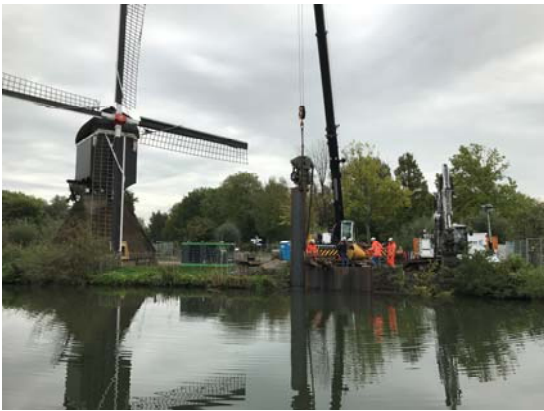
Aanbrengen nieuwe uitlaat op de Doorslag
