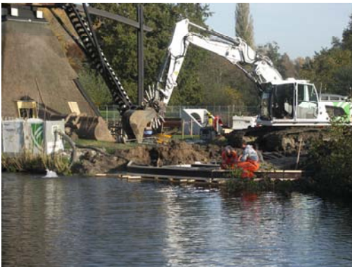
Aanbrengen nieuwe uitlaat op de Doorslag
