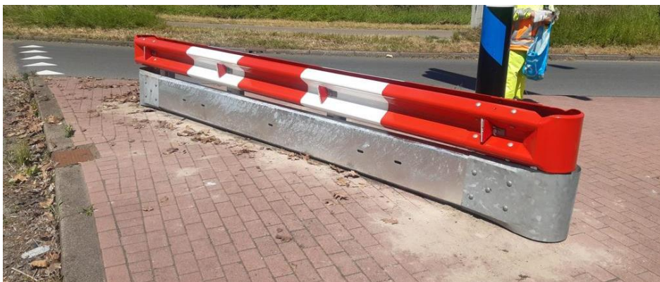
Figuur 6 Nieuwe vangrail op locatie van in figuur 5 verwijderde vangrail.
