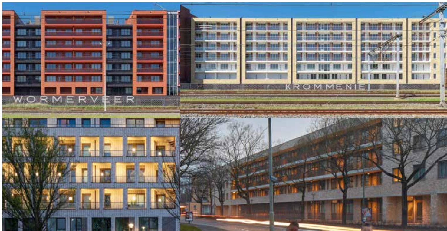
Samenhang in galerijen van de galerijflats
