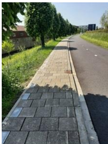
Voet/fietspad langs de Taludweg
