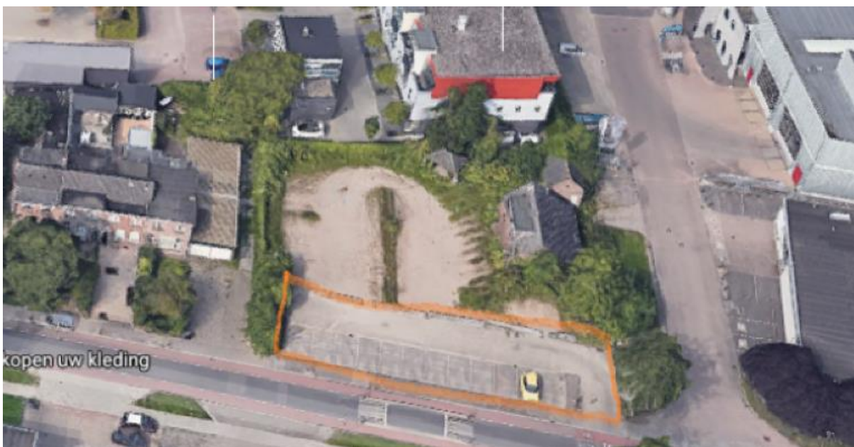
Afbeelding 2.2: Luchtfoto van de situatie vóór de sloop van de bedrijfswoning. Het reeds verharde gedeelte is omlijnd.
