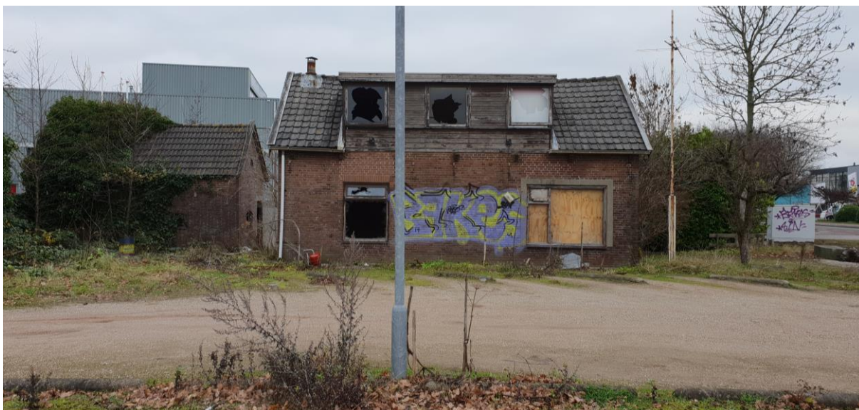
Afbeelding 2.1: Foto uit december 2019 voordat de bedrijfswoning werd gesloopt.
