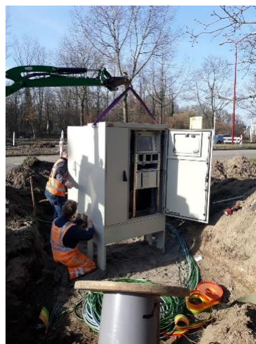
Figuur 7 Installatie van een nieuwe VRA
