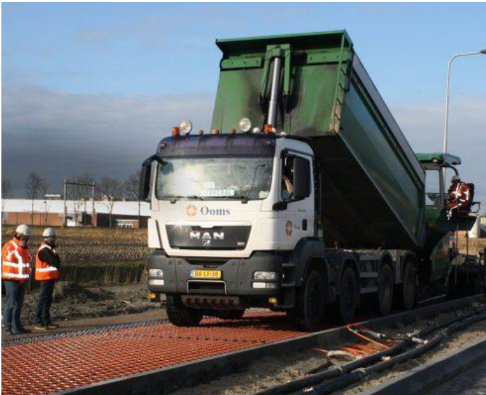
Figuur 5.5 – Weg in Heerhugowaard wordt uitgerust met asfaltcollectoren
