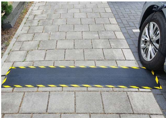
Voorbeeld van een 220V 1fase kabel met kabelmat van ten hoogste 5mm dik
