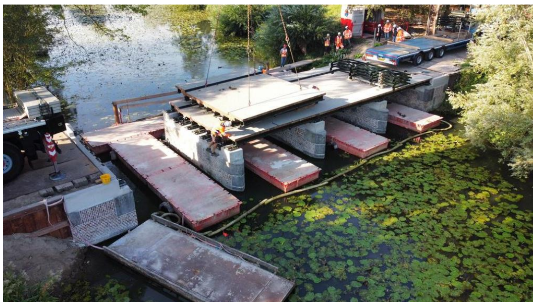
Figuur 3 Renovatie brug over het Inundatiekanaal in de Overeindseweg
