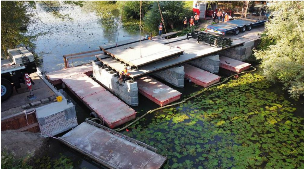
Figuur 3 Renovatie brug over het Inundatiekanaal in de Overeindseweg
