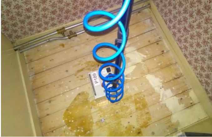
toelichting foto: pompstelling
