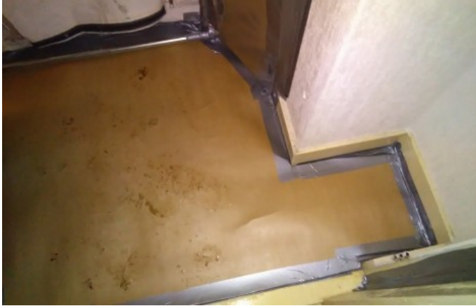
toelichting foto: vloer deels afgeplakt met stucloper en tape (voor de linker kast)
