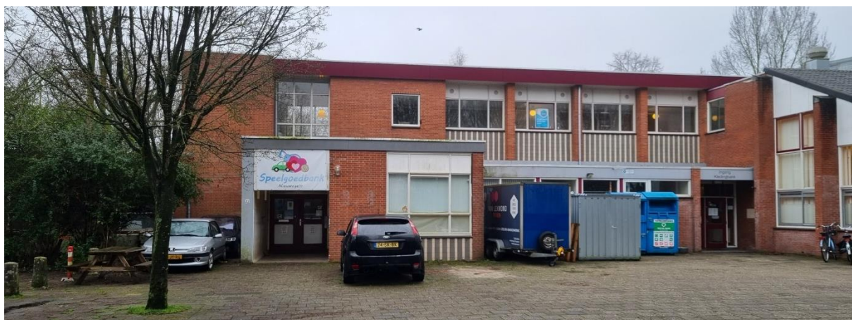
Afbeelding: Het schoolgebouw aan de Vredebestlaan
