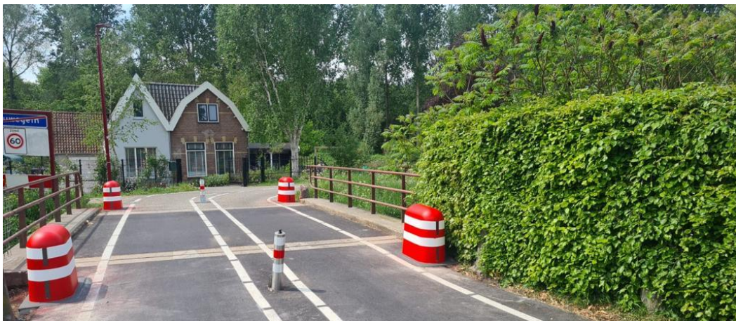
Figuur 8 Beweegbare afsluiting gelegen op het Hooglandse jaagpad tijdens de aanleg. Na het kapot rijden van de vorige afsluiting. (Op basis van een melding)
